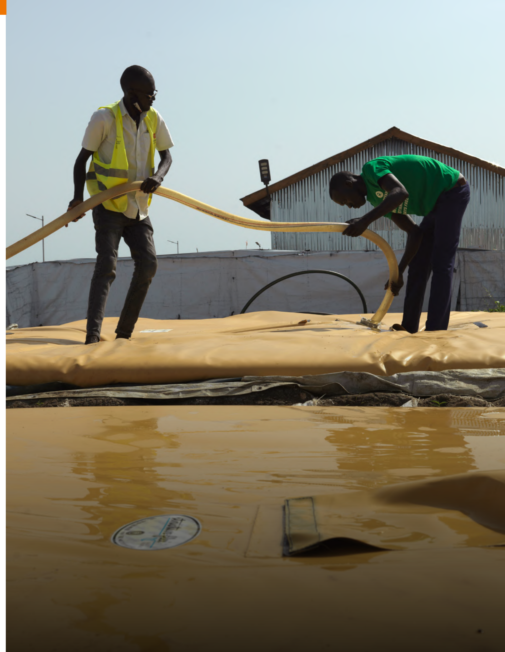
SUD SUDAN - Ingegneri di Oxfam installano una cisterna mobile per garantire acqua potabile agli sfollati sudanesi a Renk, ai confini con il Sudan.
